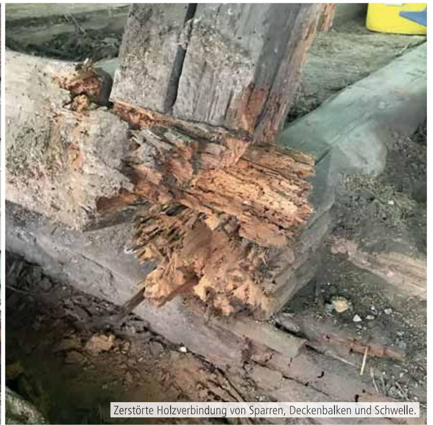
Zerstörte Holzverbindung von Sparren, Deckenbalken und Schwelle.
