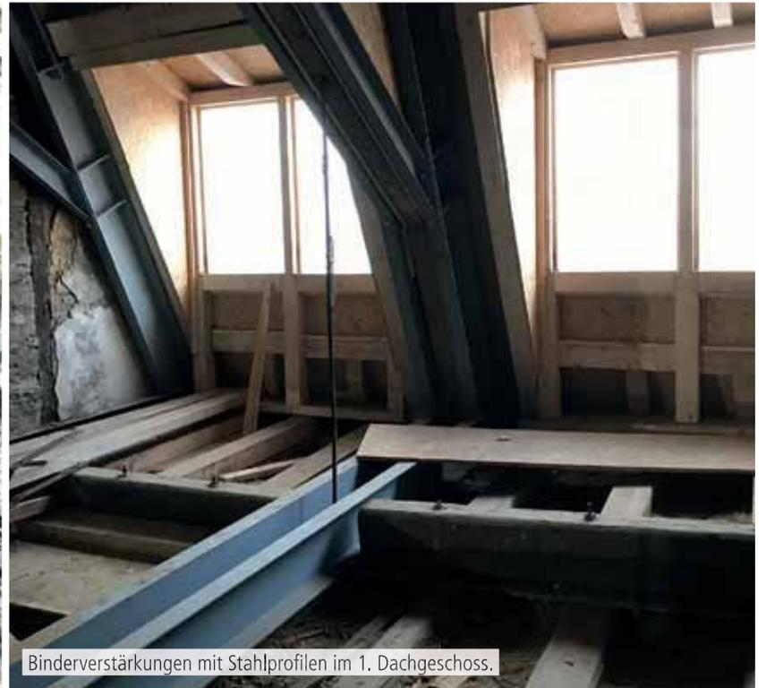
Binderverstärkungen mit Stahlprofilen im 1. Dachgeschoss.
