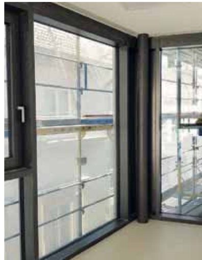
Modern, großzügig, viel Licht und Raum zeichnen sowohl die Fassaden wie auch die Innengestaltung des Neubaus aus. Fotos Jürgen Hertel
