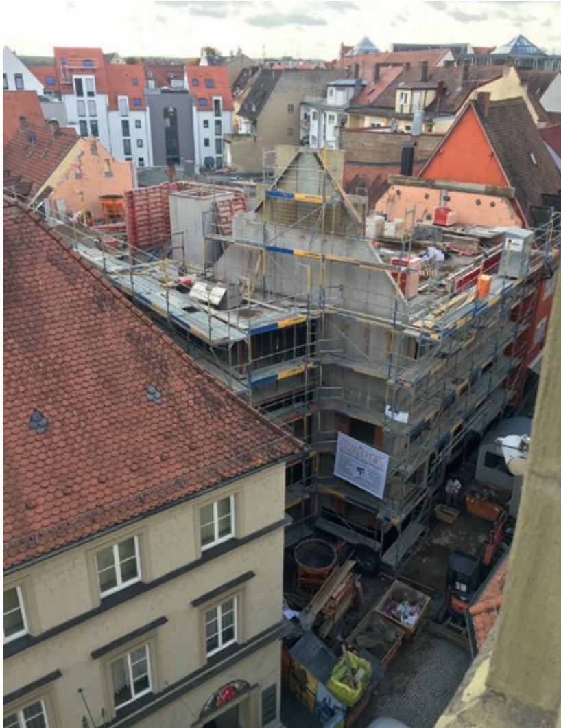
Ein Blick vom Giebel des Rathauses auf die Baustelle, Anfang November 2019, kurz vor dem Abzug der Rohbaufirma Bömmel. Zu diesem Zeitpunkt war alles für die Folgearbeit des Zimmerers vorbereitet. Die Fa. Bömmel führte an dieser logistisch schwierigen Baustelle alle Erd-, Mauer- und Betonarbeiten termingerecht innerhalb von 7 Monaten aus. Eingeschlossen war der Abbruch der vorhandenen Gewölbekeller.
