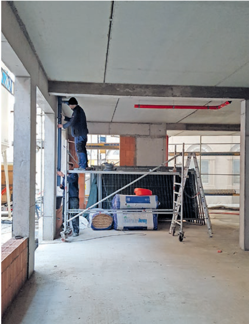
Die Firma Vielweber führt aktuell die Sanitär- und Heizungsinstallation aus. Hier werden die Entwässerungsleitungen aus den oberen Geschossen durch das Erdgeschoss mit den Grundleitungen unter der Bodenplatte verbunden.
