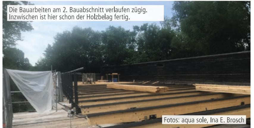
Die Bauarbeiten am 2. Bauabschnitt verlaufen zügig. Inzwischen ist hier schon der Holzbelag fertig.
