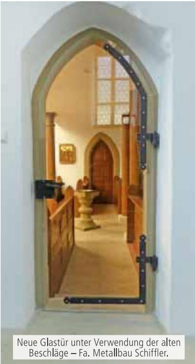
Neue Glastür unter Verwendung der alten Beschläge – Fa. Metallbau Schiffler.
